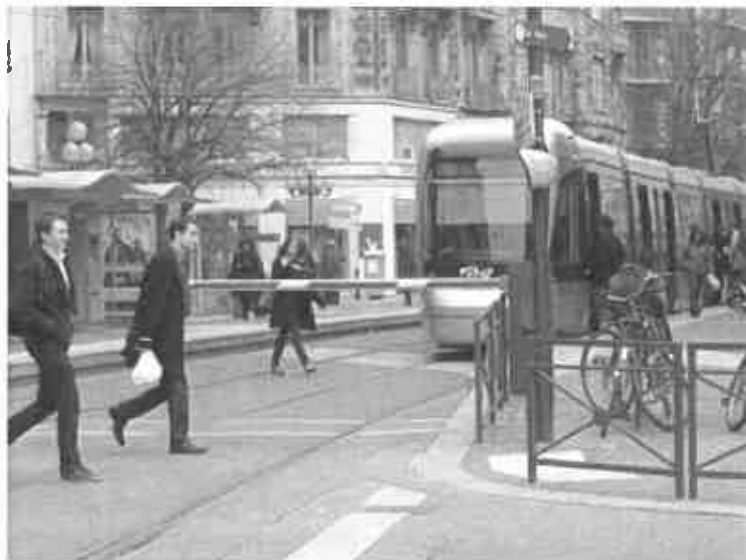
La SEMITAG a installé des demi-barrières levantes pour le tramway (Grenoble)
