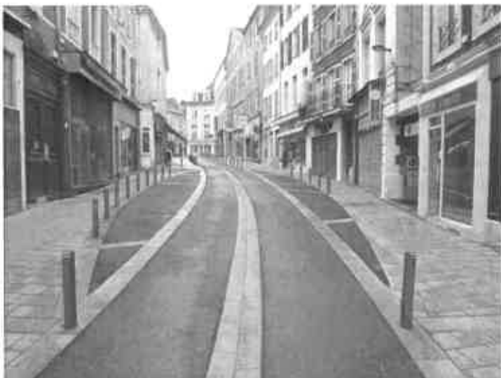
Matérialisation d'aires d'arrêt/croisement dans l'aire piétonne (Pau)
