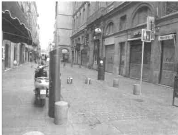
Une entrée d'aire piétonne équipée du dispositif de contrôle d'accès : totem, feu, bornes escamotables automatiques et signalisation (Toulouse).
