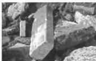
BORDURES DE TROTTOIRS
