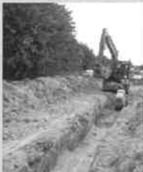
Tranchée d'une conduite d'eau potable
