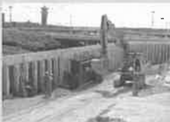
Remblaiement derrière un ouvrage d'art
