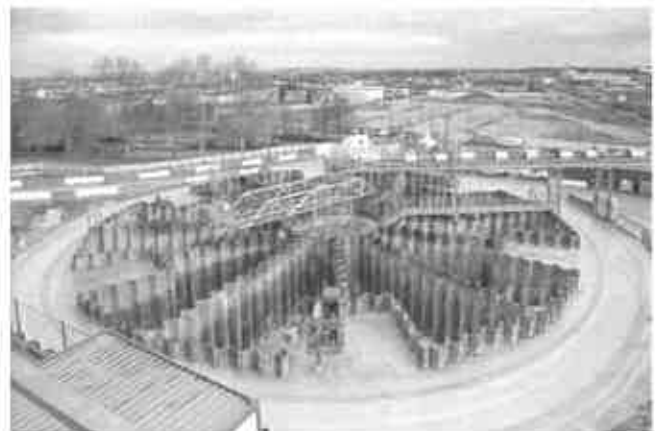
Puits de départ du tunnelier – Champigny plateau Crédits : SGP
