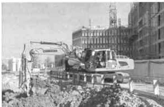
Remplissage du camion de transport des d blais - site de la future gare de Nolsy-Champs Cr dits : SGP
