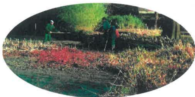
Curage d'une première partie de la mare Les boues sont exportées au moins à 3m des berges pour éviter qu'elles retournent dans le milieu curé
