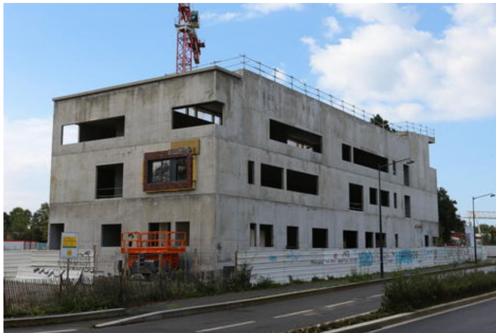
La construction de l'école de la Courrouze est stoppée depuis 2014, pour cause de pollution. Elle sera délocalisée à quelques centaines de mètres. (D. Gouray)
