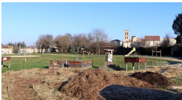
Derrière la médiathèque, un chantier participatif vient de faire surgir les premiers contours du futur jardin. — Photo Marie-Pierre Demarty
